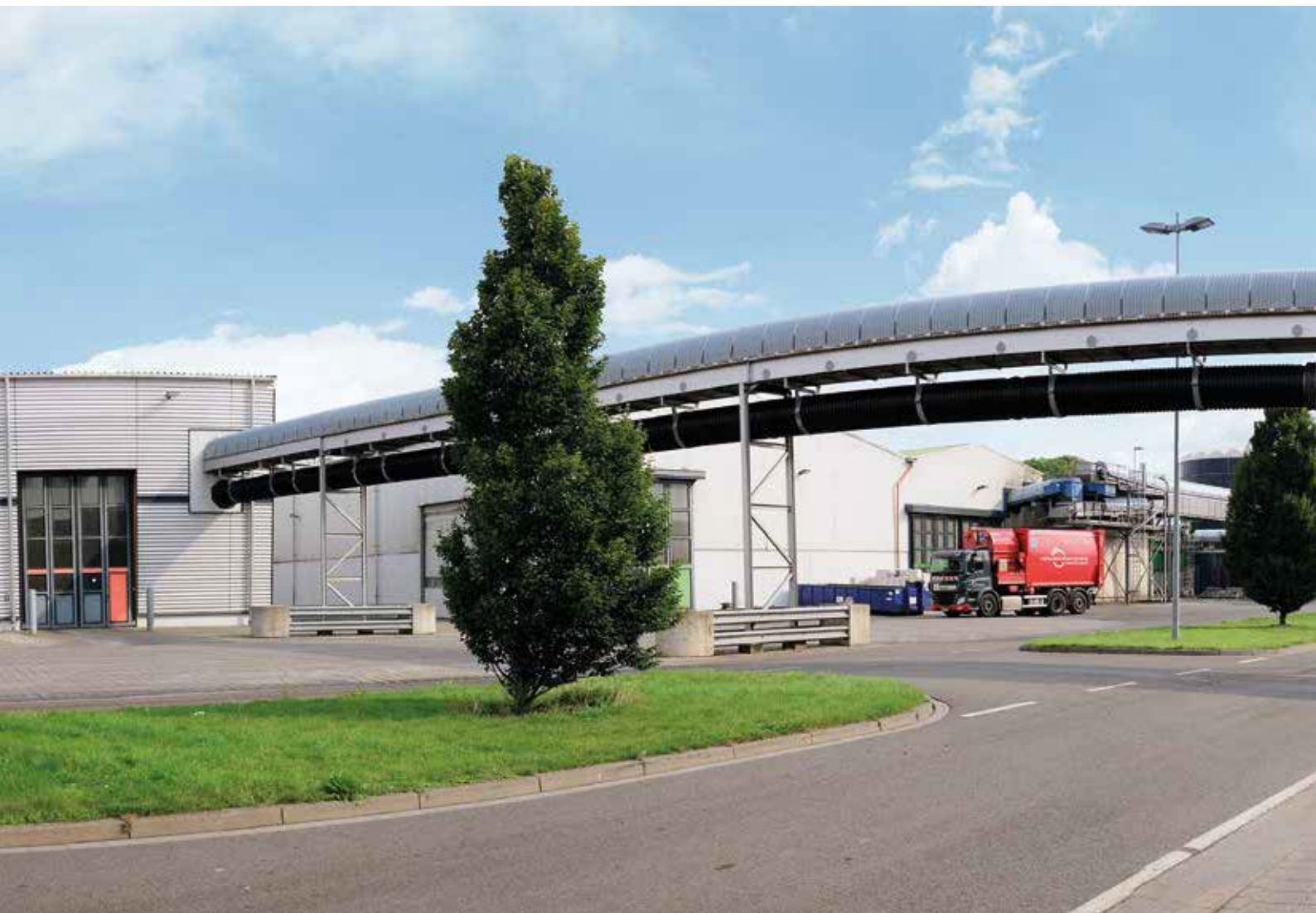
Förderbrücke zwischen MA und BA der Mechanisch-Biologischen Restabfallbehandlungsanlage
