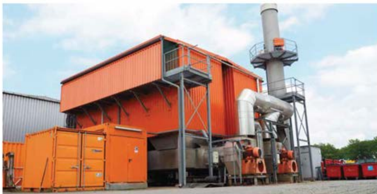
Abluftreinigungsanlage der MBA mit Abluftwäschern, RTO und Biofilter
