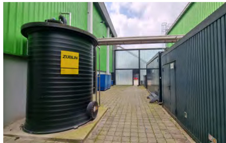
Biofilter zur Gasreinigung
