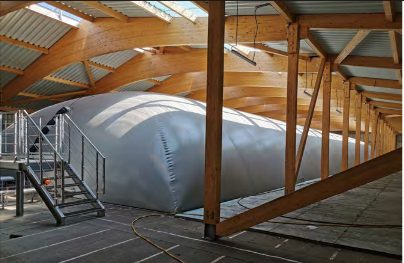
Biogasspeicher unter dem Dach der Bioabfall-Kompostierungsanlage
